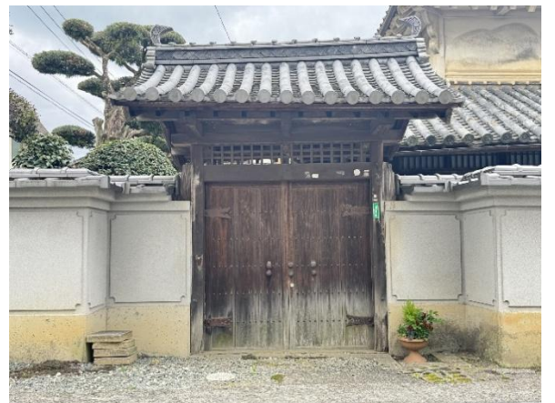
④ 坂本家住宅座敷門
