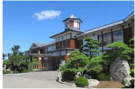
写真1 木造瓦葺の本館と3代目の時計台
